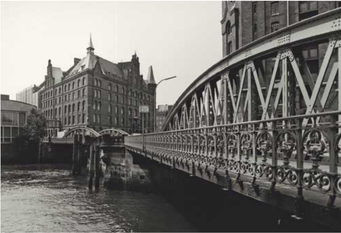
Optimiertes Bild durch Nachbelichten der hellen Bildpartie mit einer Lochblende und Abhalten der dunklen Bereiche.
